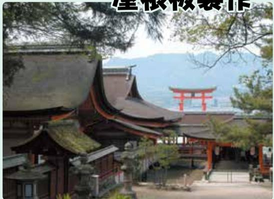
ひわだ ぶき ひのき たちき からむいた かわ 檜皮葺：檜の立木からむいた皮をうす せいけい たけぎ 薄く整形し、竹釘で打ちとめながら葺き重ねていきます。それらは、せかい さん とうろく せいのん 世界遺産に登録されている厳島神社など伝統的な古建築に残されています。ひわだ かいきうねんげん ひわだの耐久年限とされる30～40年の周期で葺き替えられ、建物を風雨から守っています。
